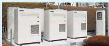
SOFC(固体酸化物形燃料電池)の導入
